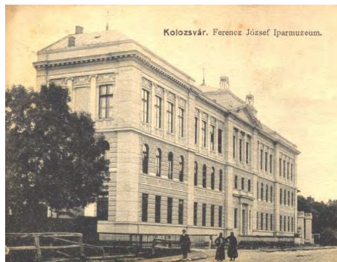
Figura 5 – G. Barițiu nr. 25 - Muzeul Industrial „Franz Iosif I”- azi Facultatea de Construcții
