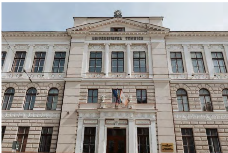
Figura 8 – Fațada clădirii G. Barițiu nr. 25
